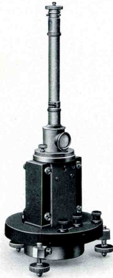
Vollständiges Spiegelgalvanometer
